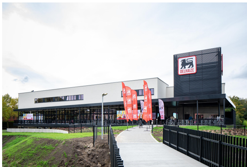
Gesloten ruwbouw van een supermarkt vppr Delhaize.
