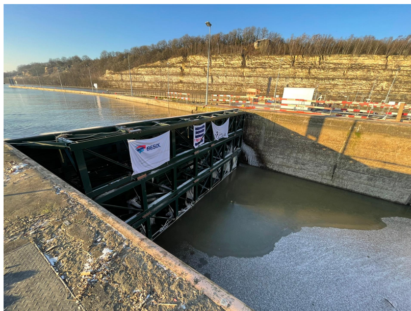
Renovatie van de sluis van Ternaaien.
