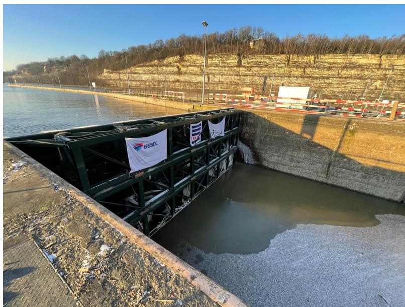
Rénovation de l'écluse de Lanaye.
