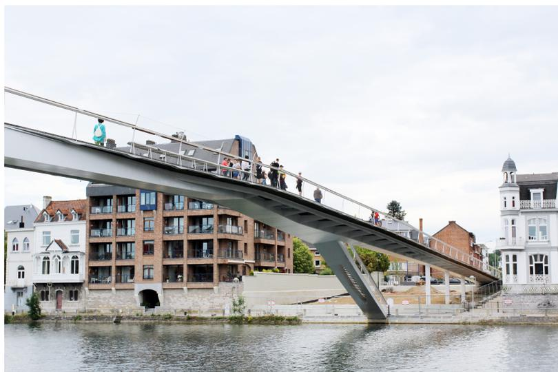
Construction d'une nouvelle passerelle cyclo-piétonne (largeur 6,2m - longueur 173m) sur la Meuse et l'aménagement d'une nouvelle place publique à Jambes. Le marché comprend aussi la démolition de 6 maisons.
