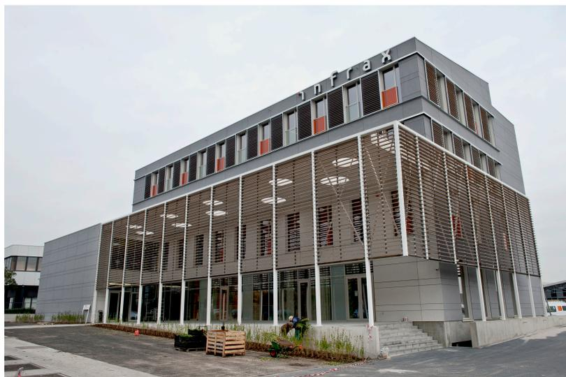
Immeuble de bureaux à haute efficacité énergétique avec parking souterrain, toits verts, récupération des eaux de pluie, utilisation de matériaux respectueux de l'environnement et mesures d'économie d'énergie, cellules photovoltaïques, chauffage par activation du noyau de béton et forage profond.
