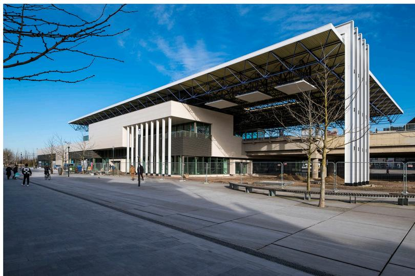
La gare de Roulers a subi un relooking complet. Une partie a été démolie pour céder la place à un bâtiment neuf, tandis qu'une autre partie a été démantelée et rénovée. Nous avons posé un plafond étanche de 2 500 m<sup>2</sup> sous le viaduc ferroviaire existant. Un nouvel auvent est également venu coiffer les voies et la gare. Durant les travaux, la gare est restée opérationnelle.
