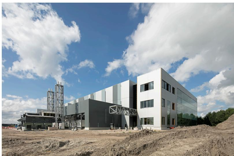
Réalisation du gros œuvre fermé du nouveau campus d'une capacité de 72 mégawatt pour le compte de l'exploitant de centres de données américain CyrusOne. Cet ouvrage est constitué de 3 500 tonnes d'acier et 4 000 m<sup>3</sup> de béton, et repose sur 3 500 piliers de fondation.
