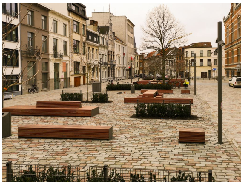
Riolerings- en bestratingswerken Moorkensplein
