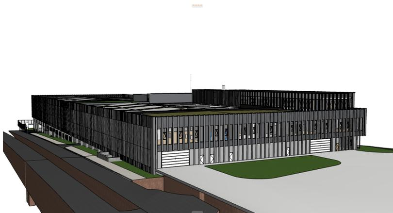
Franki Construct et Cosimco construisent conjointement un nouveau dépôt pour la STIB pouvant accueillir 190 bus hybrides. Le bâtiment principal aura une longueur de 190 m, une largeur de 70 m et une hauteur de 20 m, avec un niveau en sous-sol et trois niveaux en surface. Tous les services liés au bâtiment (électricité, données, plomberie, CVC, etc.) sont de notre ressort.
