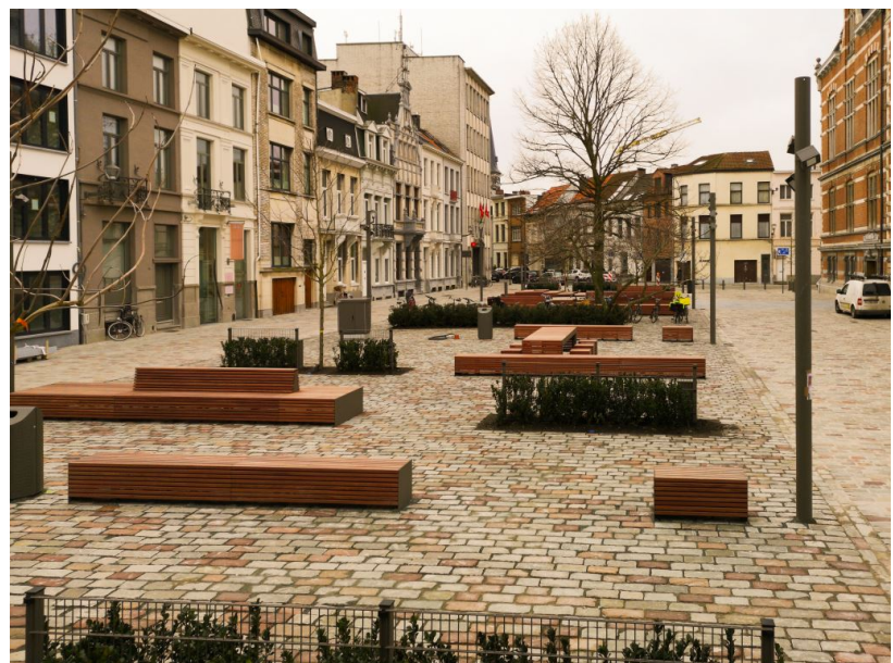
Riolerings- en bestratingswerken Moorkensplein
