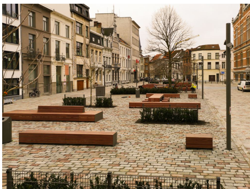
Riolerings- en bestratingswerken Moorkensplein
