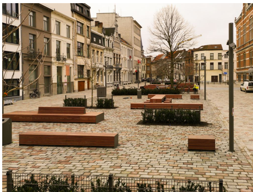
Riolerings- en bestratingswerken Moorkensplein
