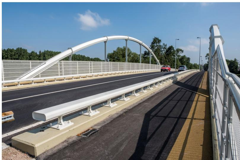
Le projet prévoit le remplacement du pont en arc sur la Moerbrugsestraat à Oostkamp, l'élargissement du pont sur le River Brook et l'adaptation du tracé de la Moerbrugsestraat entre Rivierstraat et Stationsstraat. Le nouveau pont en arc comprend deux voies pour le trafic motorisé et une piste cyclable des deux côtés.
