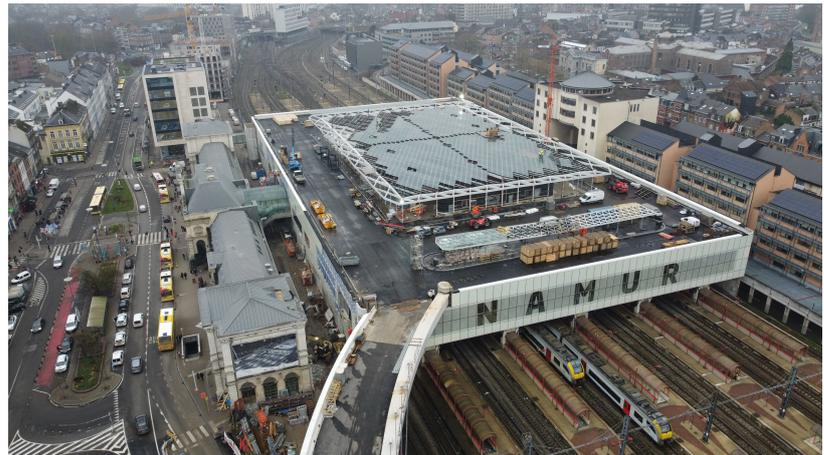
Construction d'une gare routière comportant un grand quai central et deux quais annexes sur le toit de la gare ferroviaire de Namur. La gare est totalement rénovée pendant ce chantier. La place Léopold a également été réaménagée.
