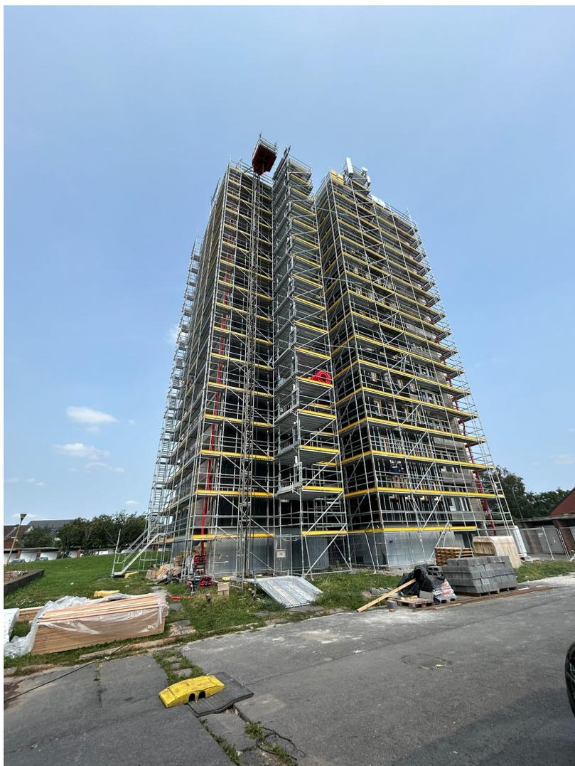
La rénovation énergétique de l'enveloppe (façades, toiture et plafond de caves) ainsi que la mise en oeuvre d'une ventilation mécanique à simple flux dans des immeubles des logements sociaux occupés.
